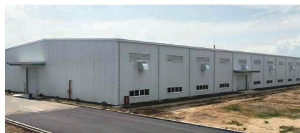
●2022年7月 生産体制を強化するため、新規に建屋を建設
