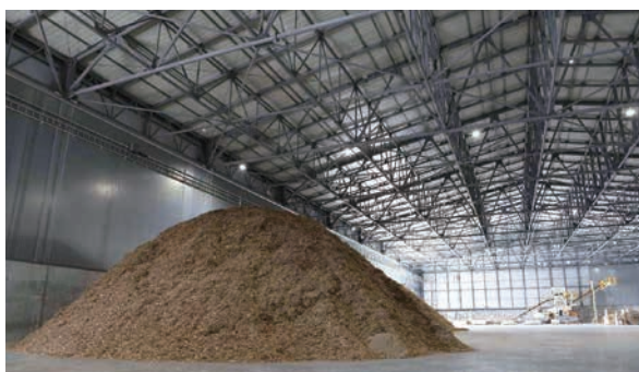
B 木材チップの保管倉庫。本格的な操業に向けて、ストックを増やしています
