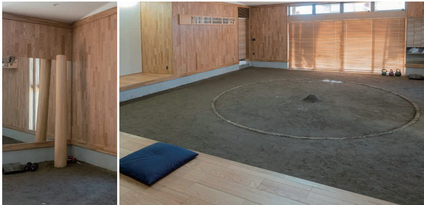
稽古場：桧のテッポウ柱と調和する壁材(ムクフローリング「プレミアムク」)を垂直面に使用
