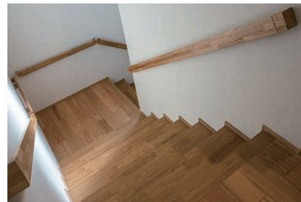
1階から2階に通じる階段：重量のある力士の利用を考慮した間口の広い丈夫な「室内階段(特注品)」
