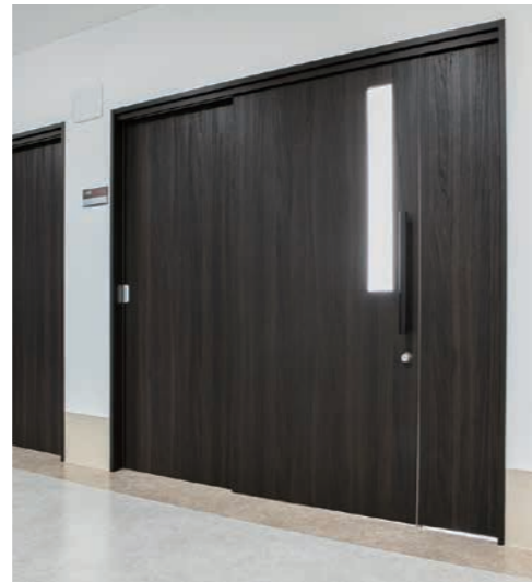
1階・2階 居室入口： 子扉を開けると開口部を広く使うことができる子扉付き片引き吊り戸
