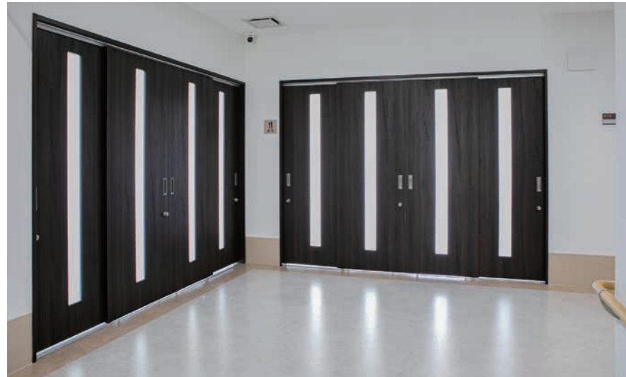
2階 食堂出入口：車いすでも食堂に正面から入ることができる、2方向に設置された大開口間仕切り吊り戸
