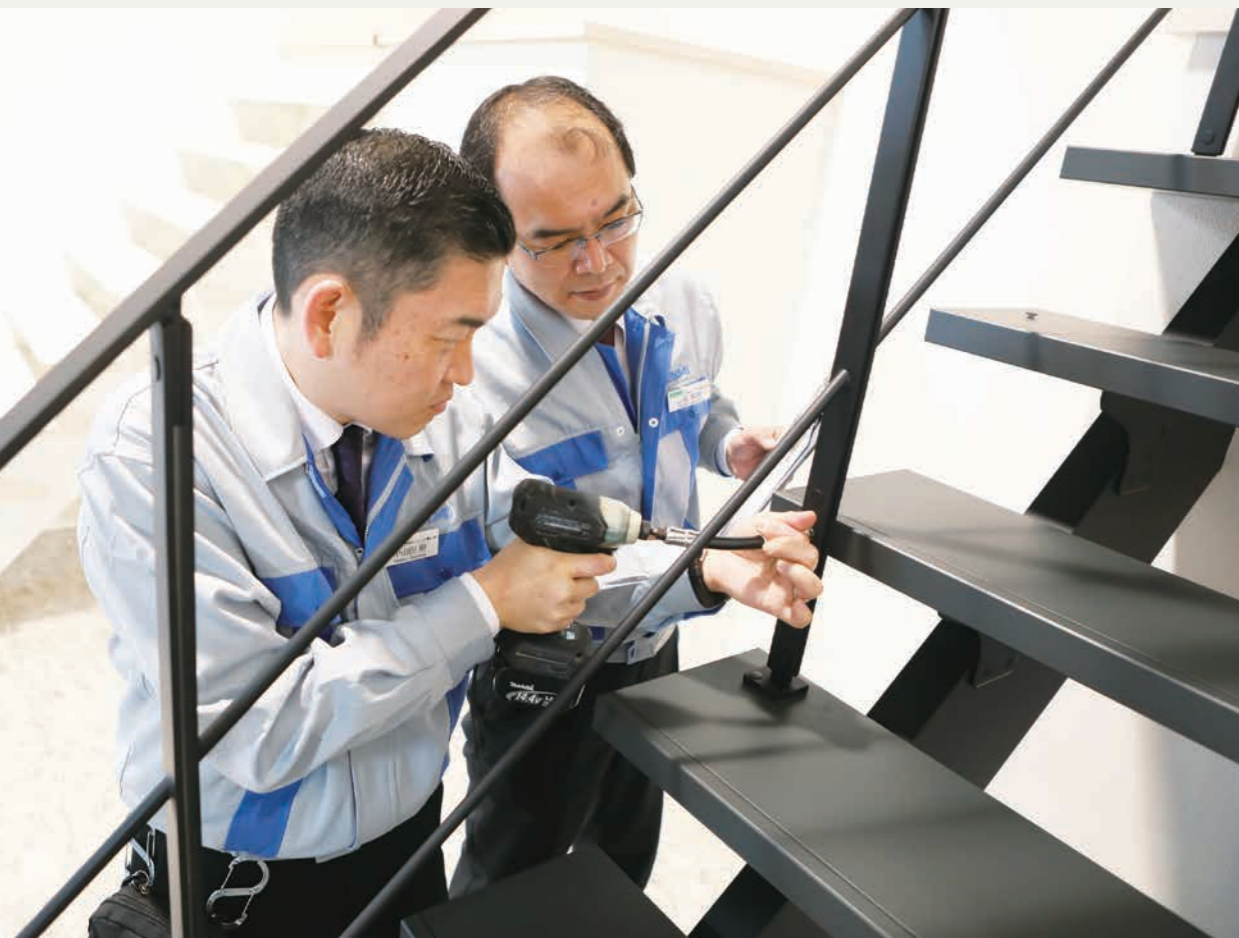
踏板の水平面だけでなく垂直面もビス留めし、より強固に固定することで安全性を向上。
