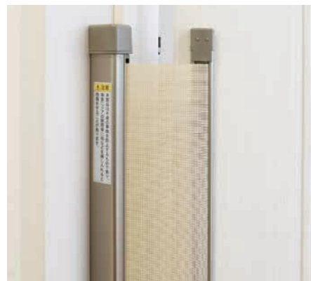
【指詰め防止部材（指はさまんぞう）】 扉の隙間に伸縮可能なネット状のスクリーンを設置して、建具の開閉時に指を挟まれないよう工夫しています。
