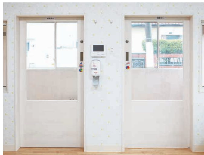
【建具】 病児・病後保育の部屋では、特にガラス窓の面積を大きく採り、部屋の中の様子を確認しやすいようにしています。
