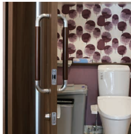
【折れ戸】 内側、外側の両方から開閉しやすい折れ戸に、レバーの上げ下げで簡単に操作できる錠を取り付けました。
