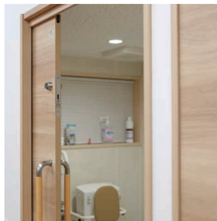
【チャイルドロックと取っ手】 子どもが誤って扉をロックしたり、開閉したりしないように錠を高い位置に設置。取っ手は握りやすいように大きくなっています。
