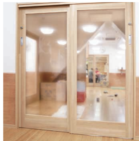
【引き違い吊り戸(全面透明アクリル)】 全面を透明にすることで、部屋の様子を確認しやすいようにしています。
