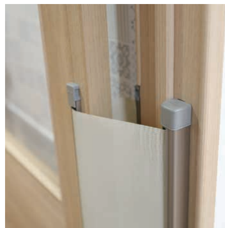
【指詰め防止部材(指はさまんぞう)】 扉の隙間に伸縮可能なネット状のスクリーンを設置して、建具の開閉時に指を挟まないよう工夫しています。
