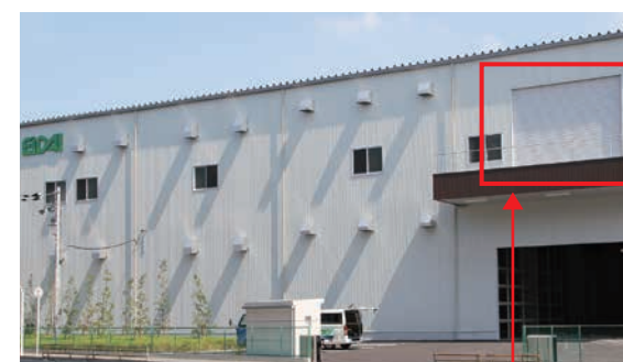
非常用の2階搬出入口
