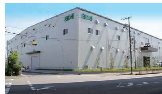
完成した本社物流倉庫の外観
