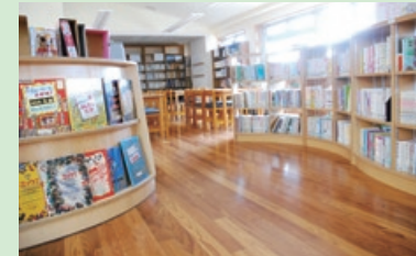
(国産圧密単板フローリング 福井県坂上市立鳴鹿小学校)
