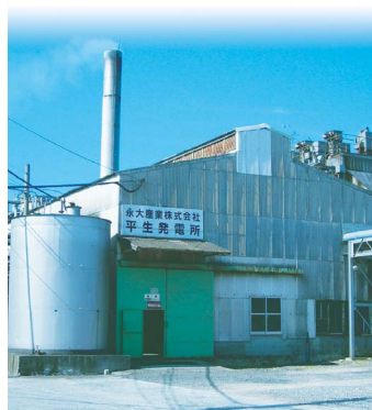
バイオマス発電所（山口・平生事業所）
